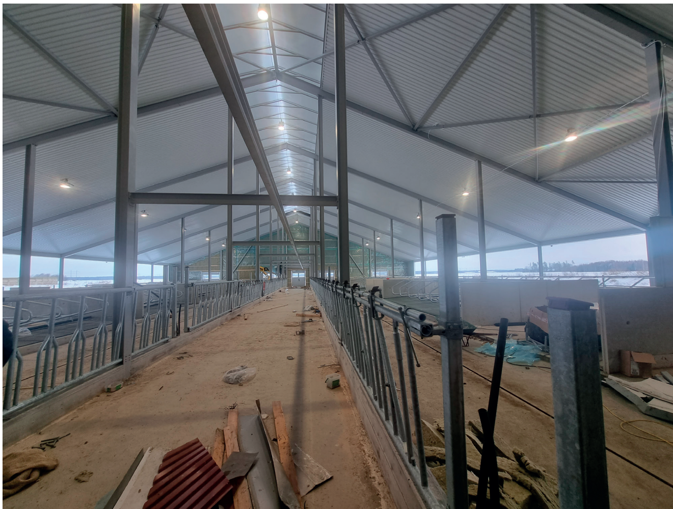
Nytt ungdjursstall under byggnation på Södra Kärrs Lantbruk
